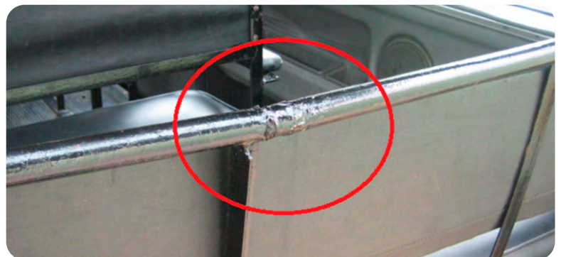
Fig. 2 Defecto estructural en camioneta relevada
